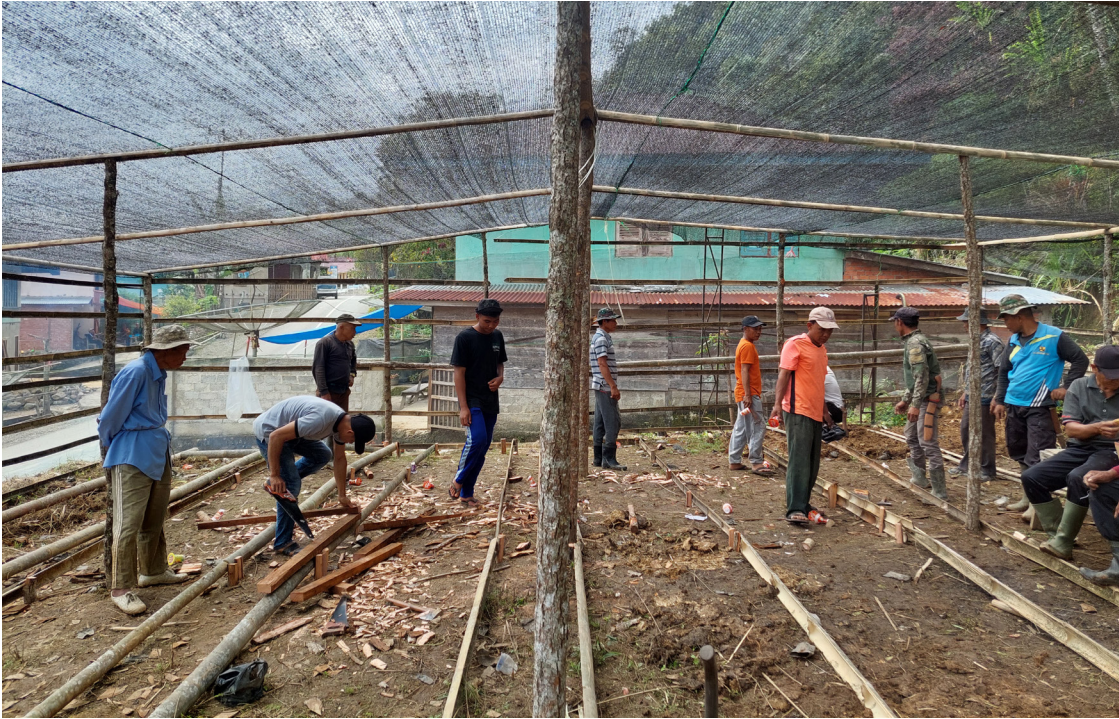
Proses pembangunan rumah semai di Desa Pungut Hilir
