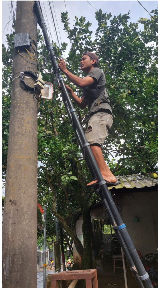
Petugas pengelola sedang memperbaiki infrastruktur jaringan di Desa Japan
